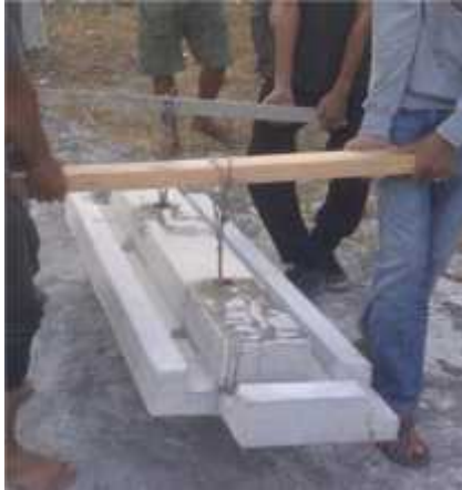
Gambar 8. bentuk elemen pracetak hasil cetakan dan metode pengangkatan elemen pracetak
