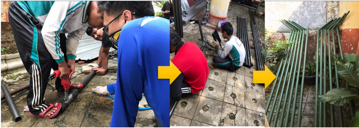
Gambar 4. Pembuatan Tiang TTG
