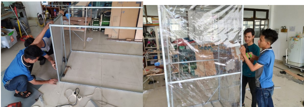
Gambar 4. Pembuatan Rangka dan Pemasangan Dinding Bilik Disinfektan
