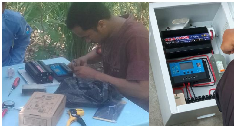
Gambar 3. Instalasi komponen control pada box panel
