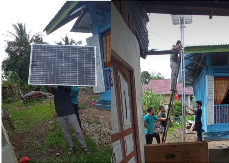
Gambar 4. Pemasangan Solar panel
