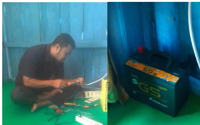
Gambar 6. Pemasangan Instalasi baterai
