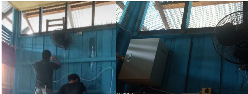
Gambar 5. Pemasangan Instalasi beban dan box panel
